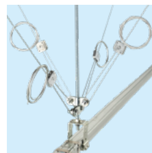
⑦ 施工完了です。
