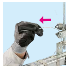
③ ワイヤーを振れ止め金具 (GRYF2-W3)に通します。
